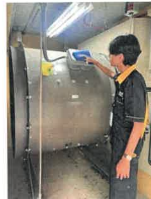
รูปที่ 50 เจ้าหน้าที่ดูแลบำรุงรักษาพัฒนา ระบายอากาศที่ติดตั้ง
