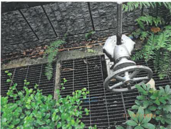
รูปที่ 21 ติดตั้งตะแกรงดักขยะในบ่อพักน้ำเสียก่อนปล่อยสู่สาธารณะ
