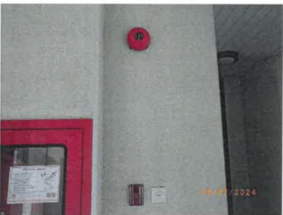
รูปที่ 51 ระบบป้องกันและเตือนอัคคีภัย
