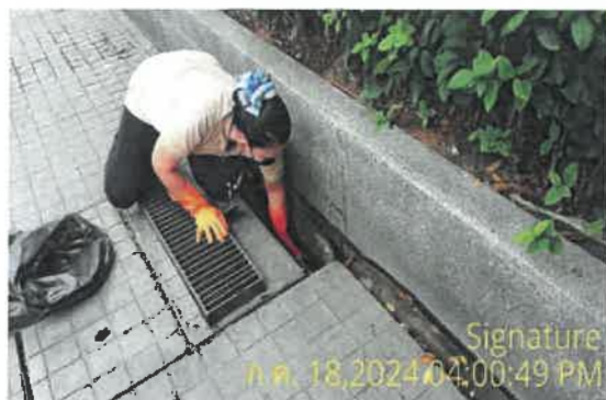
รูปที่ 22 การทำความสะอาดขุดลอกบ่อพักและท่อระบายน้ำ
