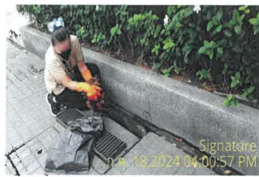
รูปที่ 22 การทำความสะอาดขุดลอกบ่อพักและท่อระบายน้ำ
