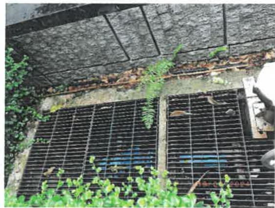
รูปที่ 21 ติดตั้งตะแกรงดักขยะในบ่อพักน้ำเสียก่อนปล่อยสู่สาธารณะ
